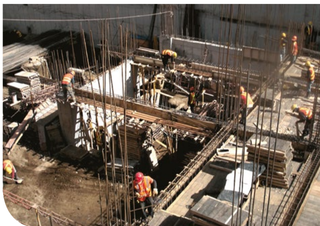
Construcción del campus.
